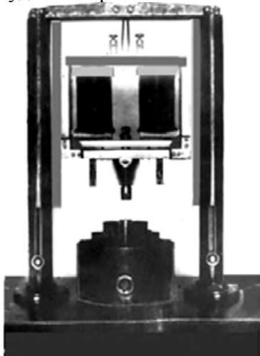
Рис. 4. Первая электроискровая установка с вибратором. 1944 г.
