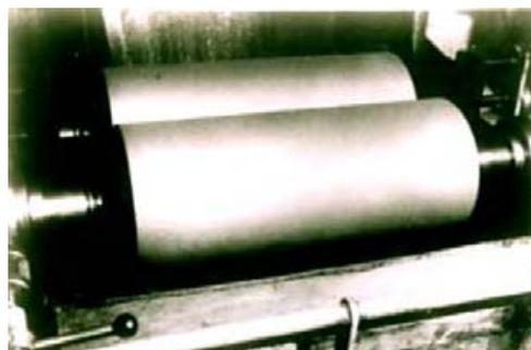
Рис. 11. Электроискровое шлифование и приработка валков мукомольных. 1960 г.
