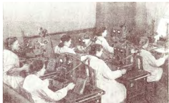
Рис.29 Часть цеха Ленинградского карбюраторного завода, где электроискровым способом изготавливают отверстия в распылителях топлива
